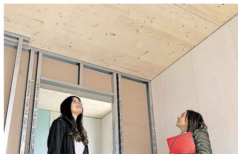
Besonderer Akzent: Die Decken aus Holz bleiben sichtbar, um die Holzbauleitung für die Bewohner unmittelbar spürbar zu machen.
