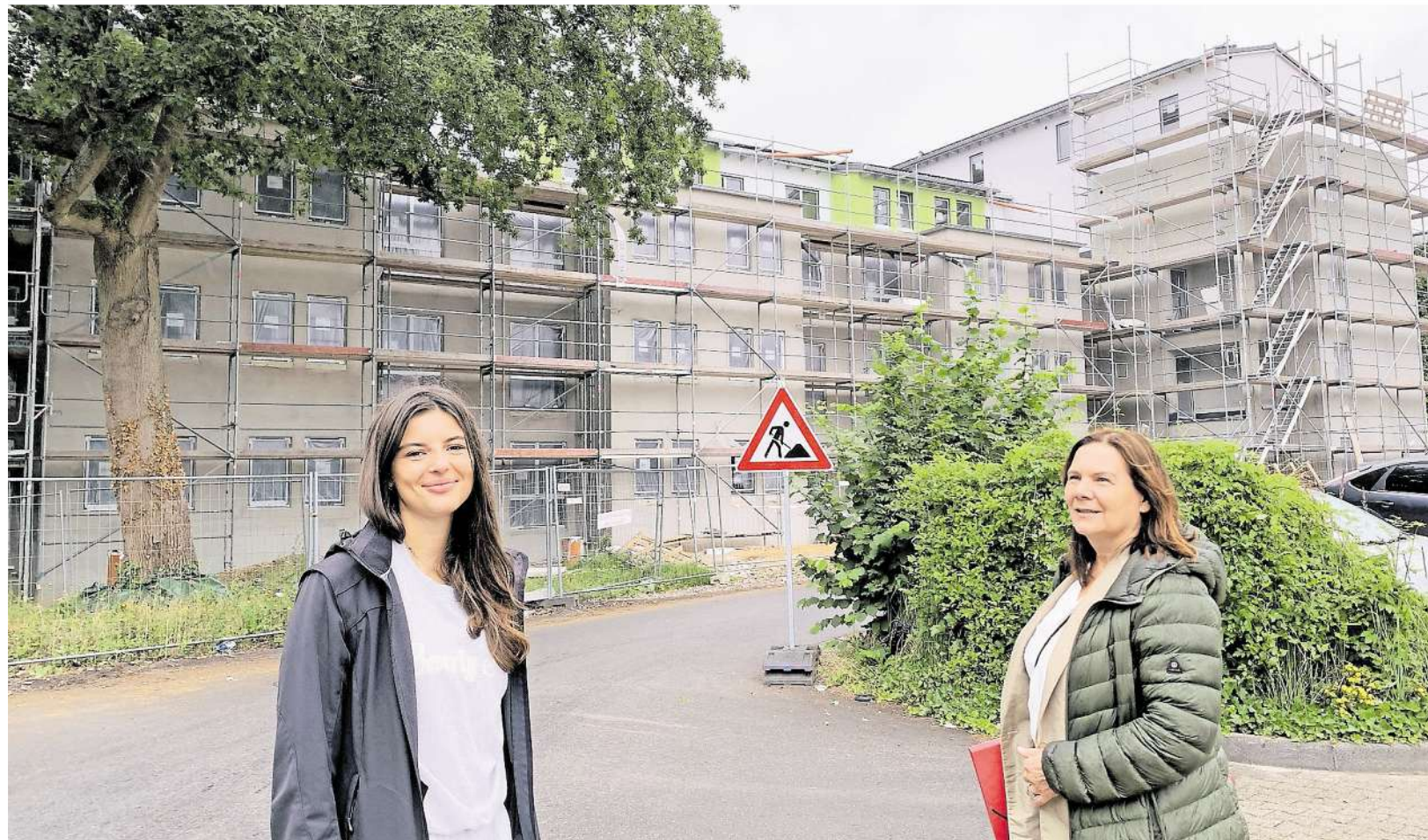
Der stattliche Baukomplex auf dem Marbaise-Gelände hat in wenigen Monaten Gestalt angenommen: Ortstermin mit Architektin Claudia Weber (r.) und Lea Schwarz (l.) vom Investor My Boardinghouse.
